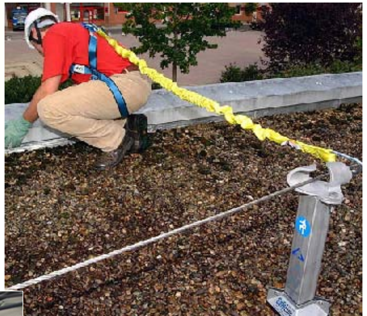
شکل ۵۴-۲- محدود کننده با اتصال یک طناب
